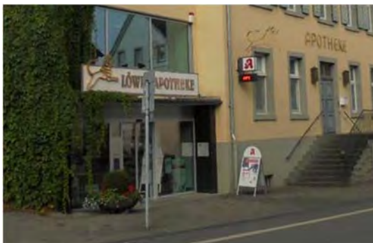
Farbakzente durch Blumenkübel und Fassadenbewuchs...
