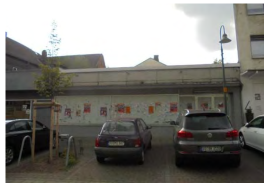
... und sollen im Rahmen des Fassaden- und Hofprogramms 2016 – 2020 erneuert werden (Bild: unterausgenutztes Grundstück Diephlohstraße)
