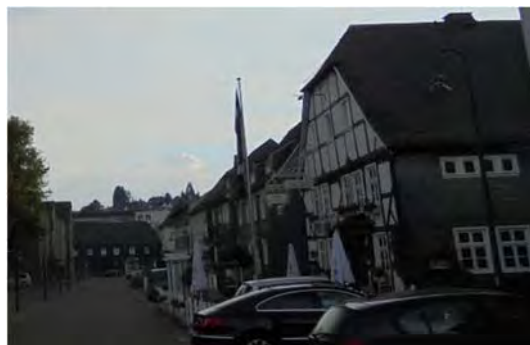
Fachwerkhäuser in der Diepholstraße
