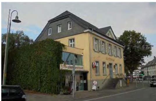
zum Teil ansprechende Gebäudesubstanz und Fassaden...
